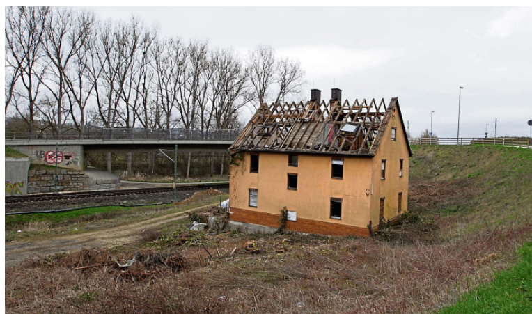
Nur noch eine Ruine: Das Gebäude am Oberboiinger Kreisverkehr „Froschländer“. Foto: Holzwarth
