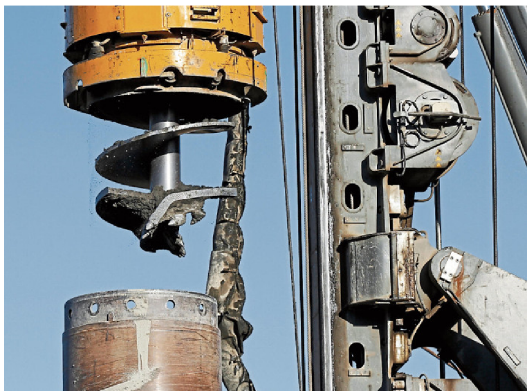
Mit schwerem Gerät werden die Arbeiten für die Beseitigung des Bahnübergangs Schützenstraße vorangetrieben.
