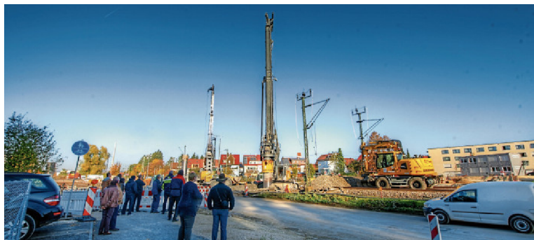
Mit 26 Meter hohen Bohrgeräten werden Löcher für die Bohrfahlwände gebohrt. Fotos: Jüptner
